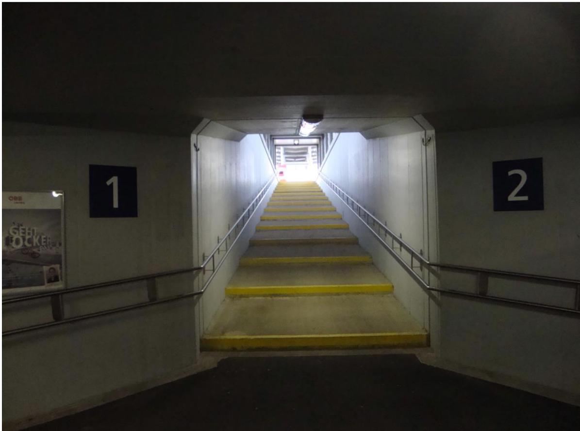
Nach technischer Prüfung hat sich ergeben, dass durch den Umbau der bestehenden Stiege (Neigung 10%) auf eine Rampe eine Neigung von ~14% erreicht wird.
