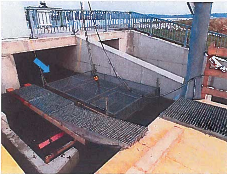
Abb. 16 Eingesetzter Reusenkasten mit seitlicher Absperrung aus hasengitterbespanntem Kunststoffpaneel; blauer Pfeil: Fließrichtung.
