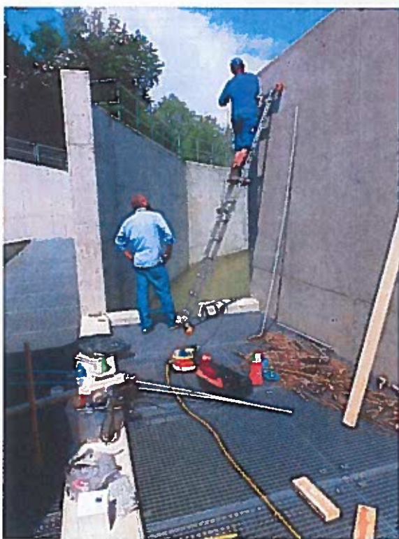
Abb. 10 Installation der Rahmenantenne im flussabwärtigen Einstiegsbereich des Fischaufstiegs KW Enns.
