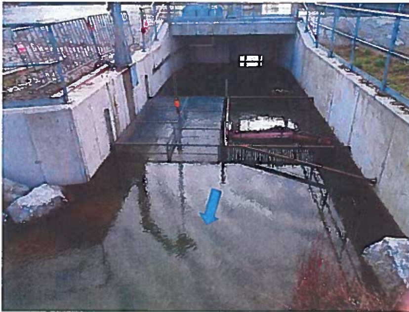
Abb. 14 Reusenkasten mit seitlicher Abspernung aus hasengitterbespannten Kunststoffpaneelen.
