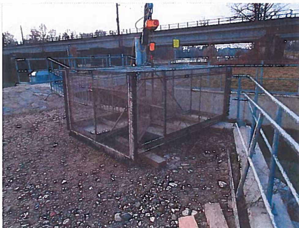
Abb. 13 Reusenkasten mit zwei Kammern für den Nachweis von auf- und absteigenden Fischen mit einer Aluminiumwanne zur schonenden Hälterung der Fische, sowie mit Bürstendichtungen am flussauf- und flussabwärtigen Reusenrahmen.
