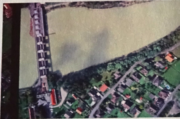
Abbildung 46: Fließstrecke bei Wehr Mühlrad.
