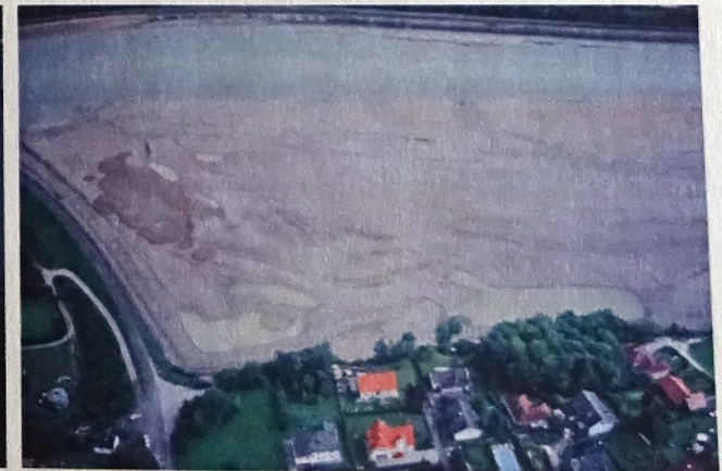
Abbildung 51: nördlicher Teil des Stauraumes oberhalb der Wehranlage Thurnsdorf.
