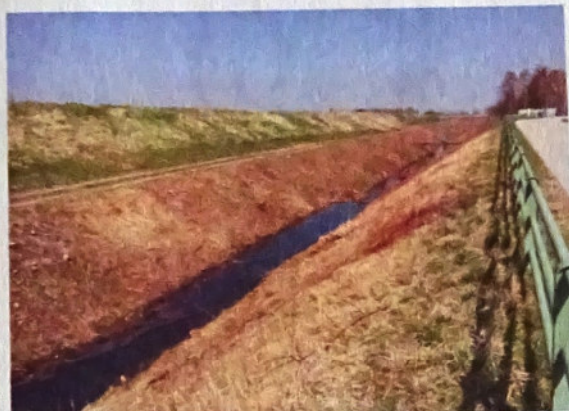
Abbildung 18: Nördlicher Teil des Entwässerungsgrabens, der Gehölzsaum wurde vollständig entfernt (Bereich des geplanten Umgehungsgerinnes).
