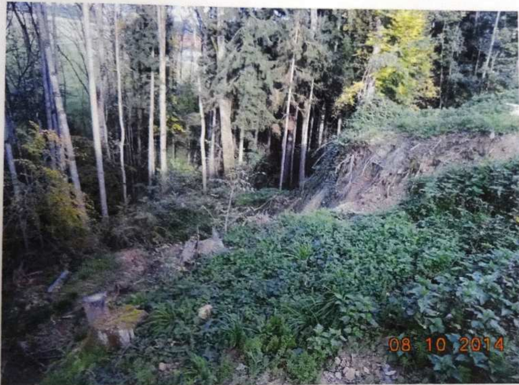
Bild 1: Hangrutschung, vom Güterweg in Richtung Krößbach
