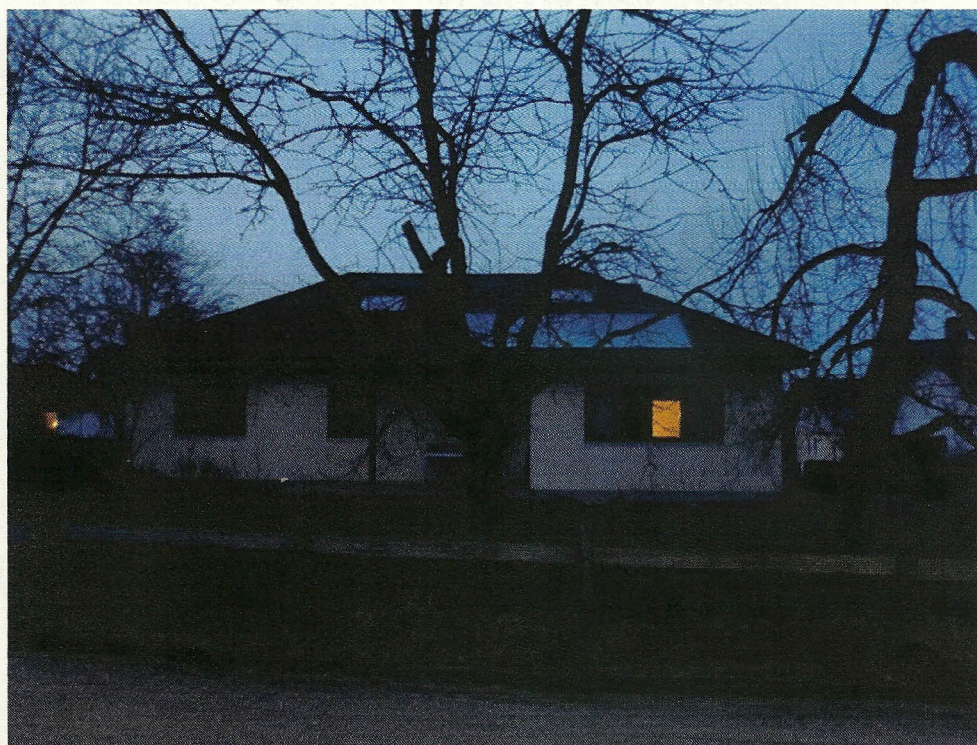
Frontansicht des Hauses Achleiten 139 mit der Terrasse und dem Schlafzimmerfenster (ganz linkes Fenster)
