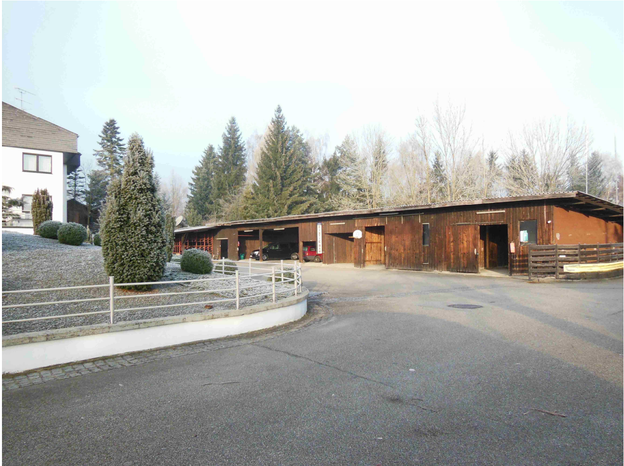
Abbildung 6: Ansicht des Baubestandes von Osten
