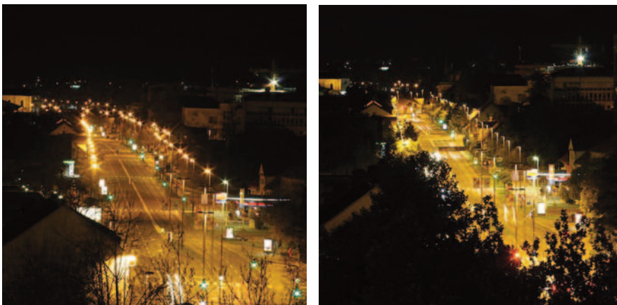
Abb. 30 - Straßenzug in Laibach: links mit Standardleuchten, rechts nach der Umrüstung auf Full-Cut-Off Leuchten. Das Ergebnis ist weniger Streulicht und Blendung sowie eine bessere Ausleuchtung der Straße
