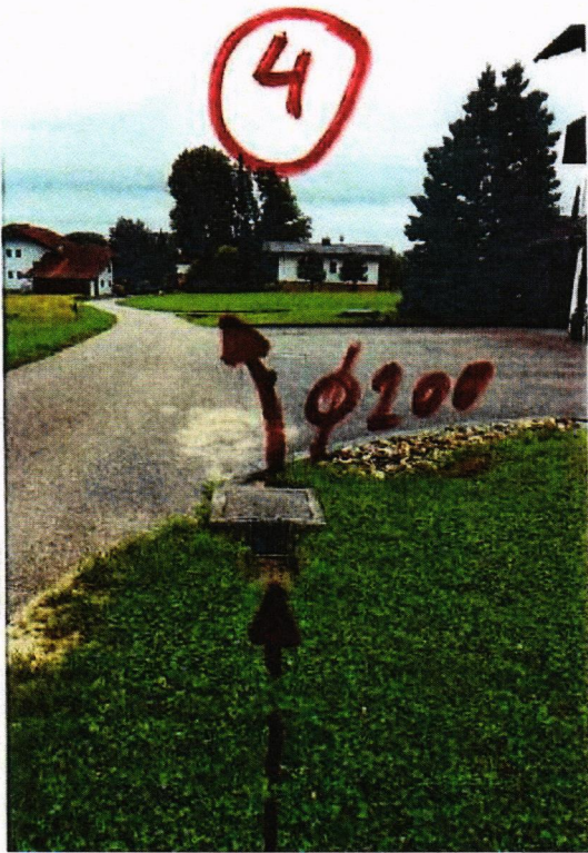
Foto 5: Ab dem Schacht ist unter der Straße eine Querung mit D250.
