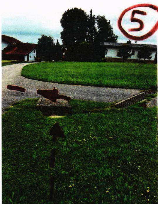
Foto 5: Ab dem Schacht ist unter der Straße eine Querung mit D250.
