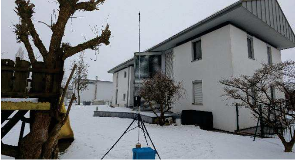
Abbildung 4: Blick in Richtung Süd
