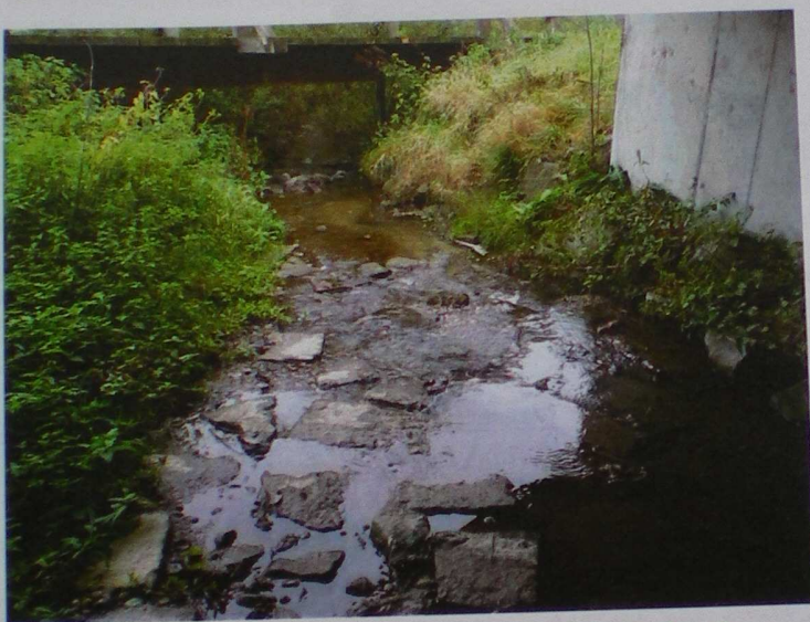
Abb. 23: Grobe Steinsicherung des Gollnbaches (Blick bachaufwärts).
