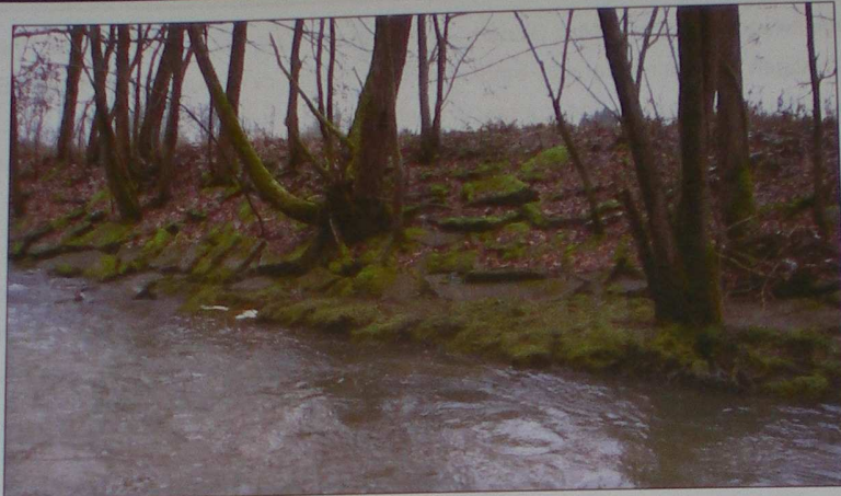
Abbildung 13: Böschungssicherung flussab der Rampe bei km 34,405
