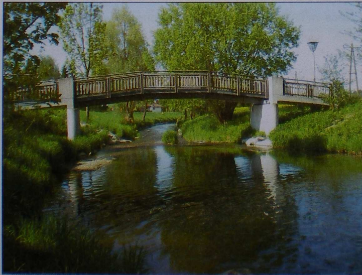
Abbildung 19: Fußgängersteg Riedau (Fluss-km 36,920)
