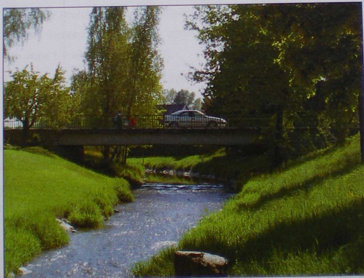
Abbildung 24: Hargassnerbrücke Riedau (km 36,460) gegen die Fließrichtung (Mai 2006)
