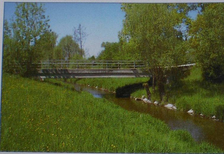
Abbildung 32: Wirtschaftsbrücke in Zell an der Pram (km 35,385)
