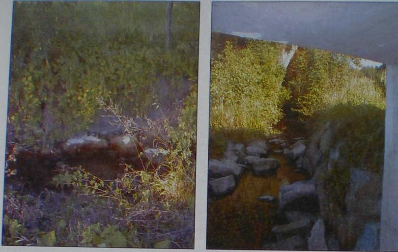
Abbildung 37: Steinsicherung am Gollnbach, Gollnbach flussauf der B137
