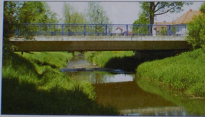
Abbildung 38: Bezirksstraßenbrücke Zell/Pram (km 34,865) in Fließrichtung
