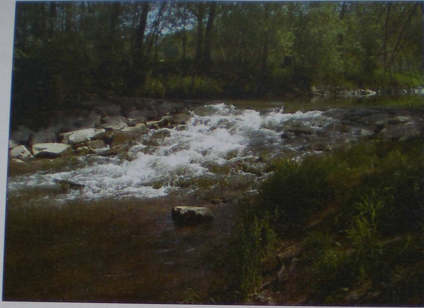
Abbildung 45: Rampe bei Fluss-km 34,420 (Nähe alte Kläranlage Zell/Pram)
