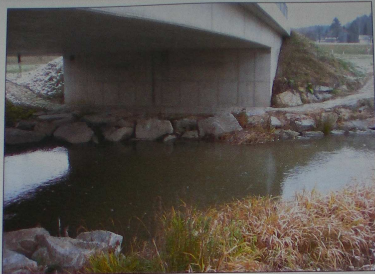
Abbildung 44: Sicherung der Widerlager im Bereich der Griesbacher Straße
