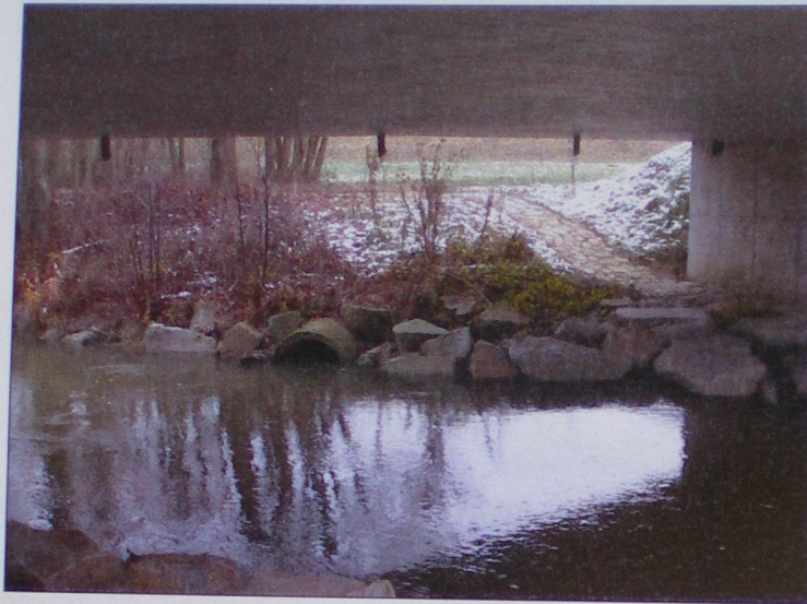
Abbildung 47: Dotierung des Altarmes über ein Betonrohr
