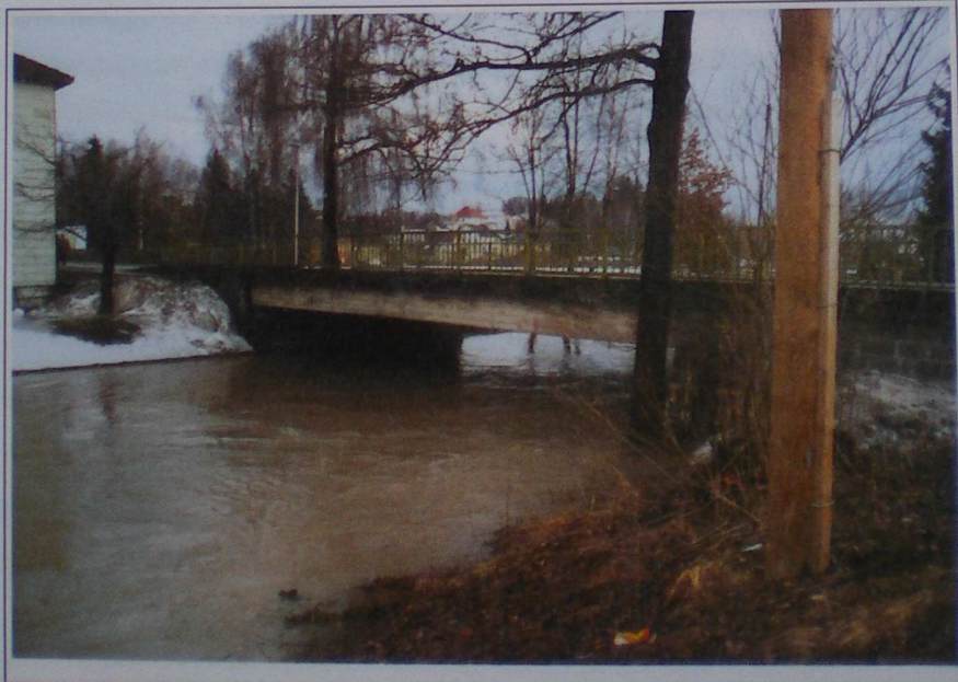
Abbildung 50: Bundesstraßenbrücke Riedau (26.03.2006 – 18:30 Uhr)
