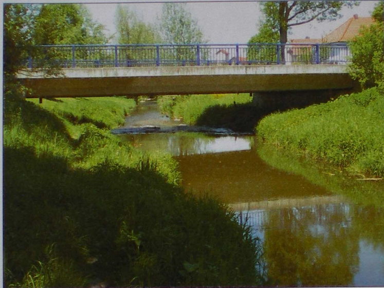
Abbildung 58: Bezirksstraßenbrücke in Zell/Pr. bei Niederwasserabfluss (12.05.2006)
